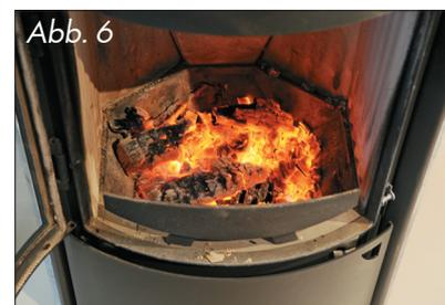
lassen Sie diese Holzauflage mit auf "AUF" stehender Primär- und Sekundärluft herunterbrennen, bis kaum noch Flammen vorhanden sind und das Holz in die Glutphase übergeht (Abb. 6).
