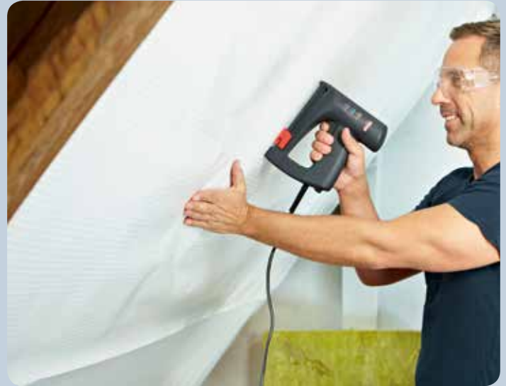
Folie beim Dachbodenausbau einfach befestigen.
