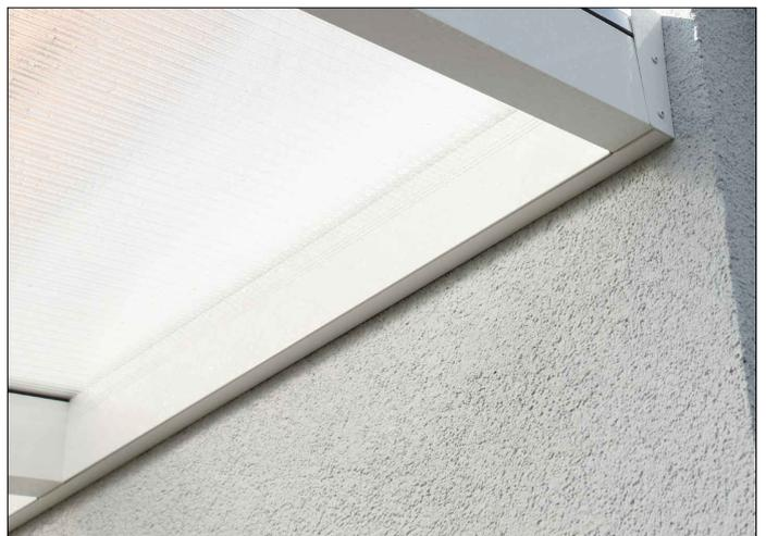
Bringen Sie die Blendleisten mit dem Klick-System an. Nach erneutem Ausrichten der Konstruktion verfüllen Sie die Fundamentlöcher mit Beton und lassen ihn härten bevor Sie mit der weiteren Montage fortfahren.
