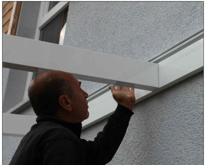
Verteilen Sie die anderen Sparren mit Hilfe der Blendleisten (dienen als Abstandhalter), bohren Sie die Schraublöcher mit einem 4mm Metallbohrer vor und verschrauben Sie die Sparren mit jeweils einer Karoserieschraube (C101-025) an den beiden Pfetten.
