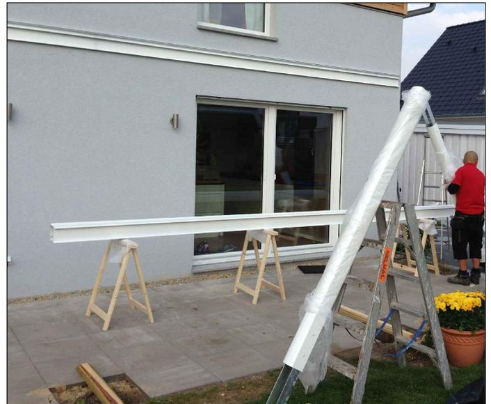
Legen Sie die Rinnenpfette und die mit den Pfostenlaschen versehenen Pfosten zur Montage bereit. Aus statischen Gründen dürfen die beiden äußeren Pfosten seitlich maximal 50cm eingerückt werden!
