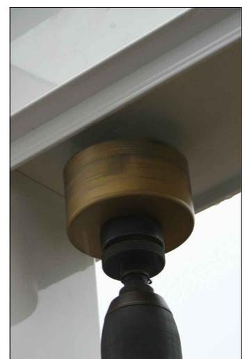
Mit einer Bohrkrone (Durchmesser 68-70mm) bohren Sie jetzt den Anschluß für das Fallrohr. Es kann sowohl neben als auch im Pfosten verbaut werden. **Bitte beachten Sie dabei den Versatz in der Rinnenpfette (siehe Detailzeichnung) sowie den Abstand der Clipphalter für das Fallrohr zum Pfosten ! (ca. 2cm)**
