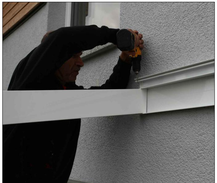
Bohren Sie die Schraublöcher mit einem 4mm Metallbohrer vor und verschrauben Sie die Sparren mit jeweils einer Karoserieschraube (C101-025) an den beiden Pfetten.
