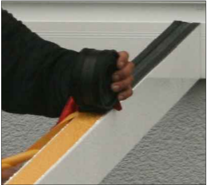
Das Unterlegband mit Hilfe des doppelseitigen Klebebandes auf den Sparren verlegen.
